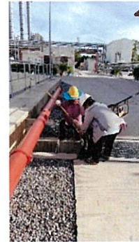
ภาพที่ 2.2-18 การทำความสะอาดรางระบายน้ำภายในพื้นที่โครงการ
