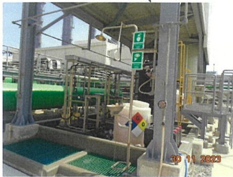
ภาพที่ 2.2-25 อุปกรณ์ชำระล้างฉุกเฉิน (Emergency Shower and Eye Wash Fountain)
